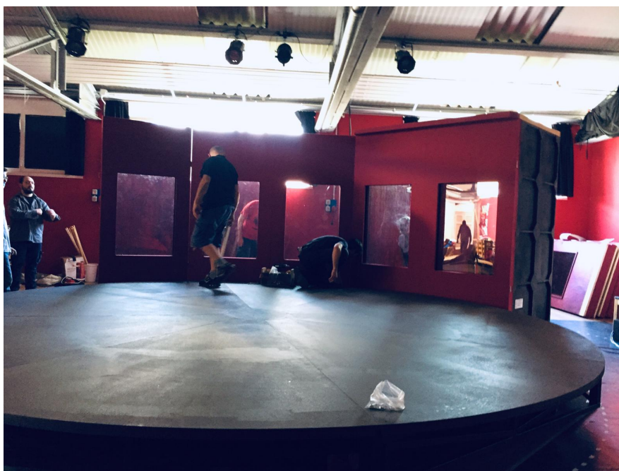
Una fase del montaggio
